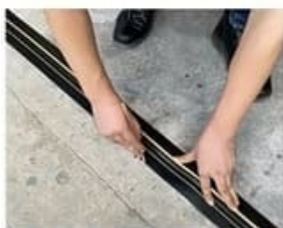
4. Zaznacz dokładną pozycję uszczelki
