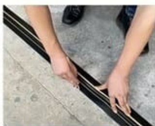
4. Zaznacz dokładną pozycję uszczelki
